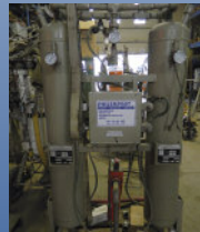
Assécheur d'air à colonnes HL145, autogénérative, 250 CFM
